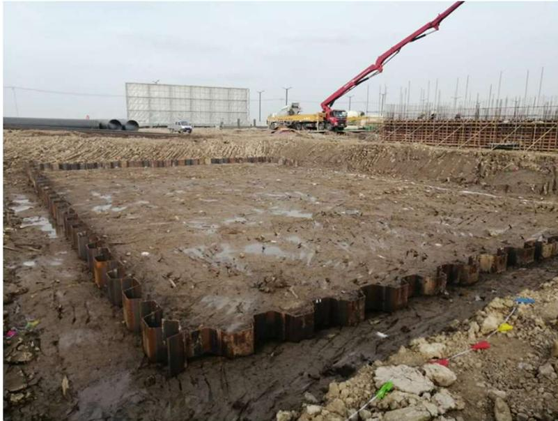
Die Lianyungang Petrochemical Co., Ltd befindet sich in einer der sieben nationalen petrochemischen Industriebasen im Bezirk XuWei, Hafen Lianyungang, Provinz Jiangsu. Das Unternehmen realisiert ein umfassendes Verarbeitungs- und Nutzungsprojekt für leichte Kohlenwasserstoffe mit einer Gesamtproduktion von 3,2 Mio. Tonnen pro Jahr. Die Spundwände wurden für Gründungsarbeiten verwendet
